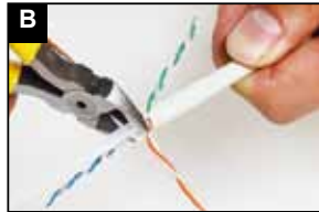
去除暴露的六类4对屏蔽双绞线外的十字分线架
