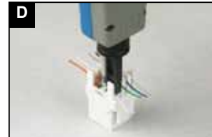
采用LINKBASIC兰贝110型单对打线工具，将导线压入IDC打线柱夹子内
