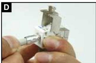
D 按照颜色线序戴上锁扣式端接帽
