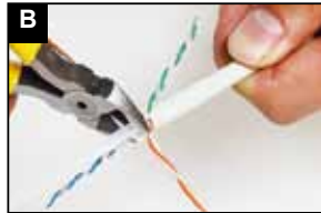
B 去除暴露在六类4对屏蔽双绞线外的十字分线架
