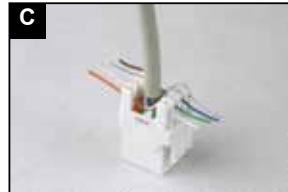
C 将导线按所定的线序要求依次嵌在对应的端接模块线槽中
