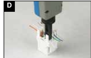
D 采用LINKBASIC兰贝110型单对打线工具, 将导线压入IDC打线柱夹子内
