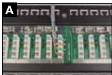
A 将导线按所定的线序要求依次嵌入对应的卡线槽中
