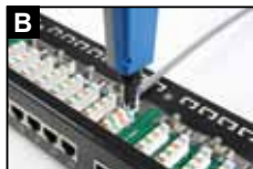
B 采用LINKBASIC兰贝单对110型打线工具, 将导线压入IDC打线柱子内
