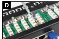
D 插入非屏蔽跳线, 实现导通
