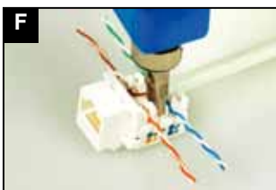
F 采用LINKBASIC兰贝110型单对打线工具, 将导线压入IDC打线柱夹子内
