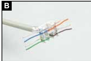
将导线按所定的线序要求依次嵌在对应的端接模块线槽中
