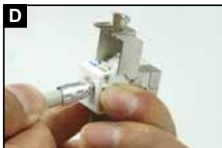
按照颜色线序戴上锁扣式端接帽
