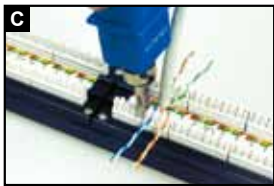
采用LINKBASIC兰贝单对110型打线工具,将导线压入IDC打线柱夹子内
