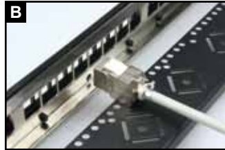
将已完成压接的模块置于背板背部
